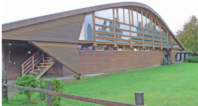
Holz ist ideal für tragende Dachkonstruktionen mit großen Spannweiten.
