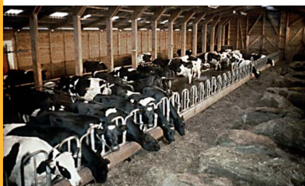
Hohe Ställe aus Holz sind kostengünstig und bieten den Tieren ein angenehmes Luftklima.
